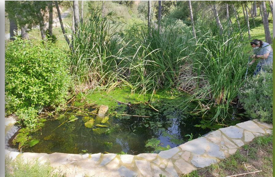
Humedales de flujo subsuperficial con fango de ETAP como material filtrante (2 celdas en serie de 20 m<sup>2</sup> cada una).
