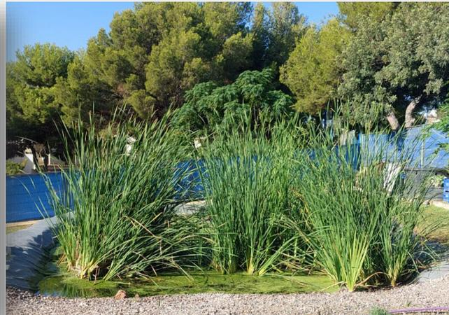
Humedal de flujo subsuperficial con fango de ETAP como material filtrante (1 celda de 60 m<sup>2</sup>).
